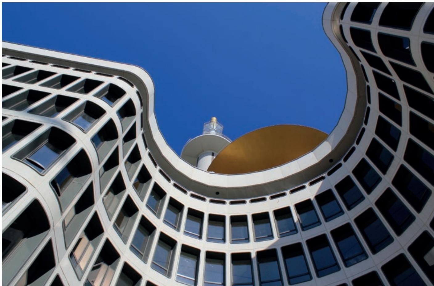
La Mabilais, Rennes (35) - Architecte : Unité - Entreprise : Aluvair - Photo : Erwans
