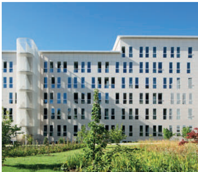
Park Azur : Nouveau siège social du Centre National pour la Recherche Nucléaire (CNEN), Montrouge (92) Architecte : Prat Gigou Ridgway - Entreprise : Duval Metalu - Photo : Michel Denancé
