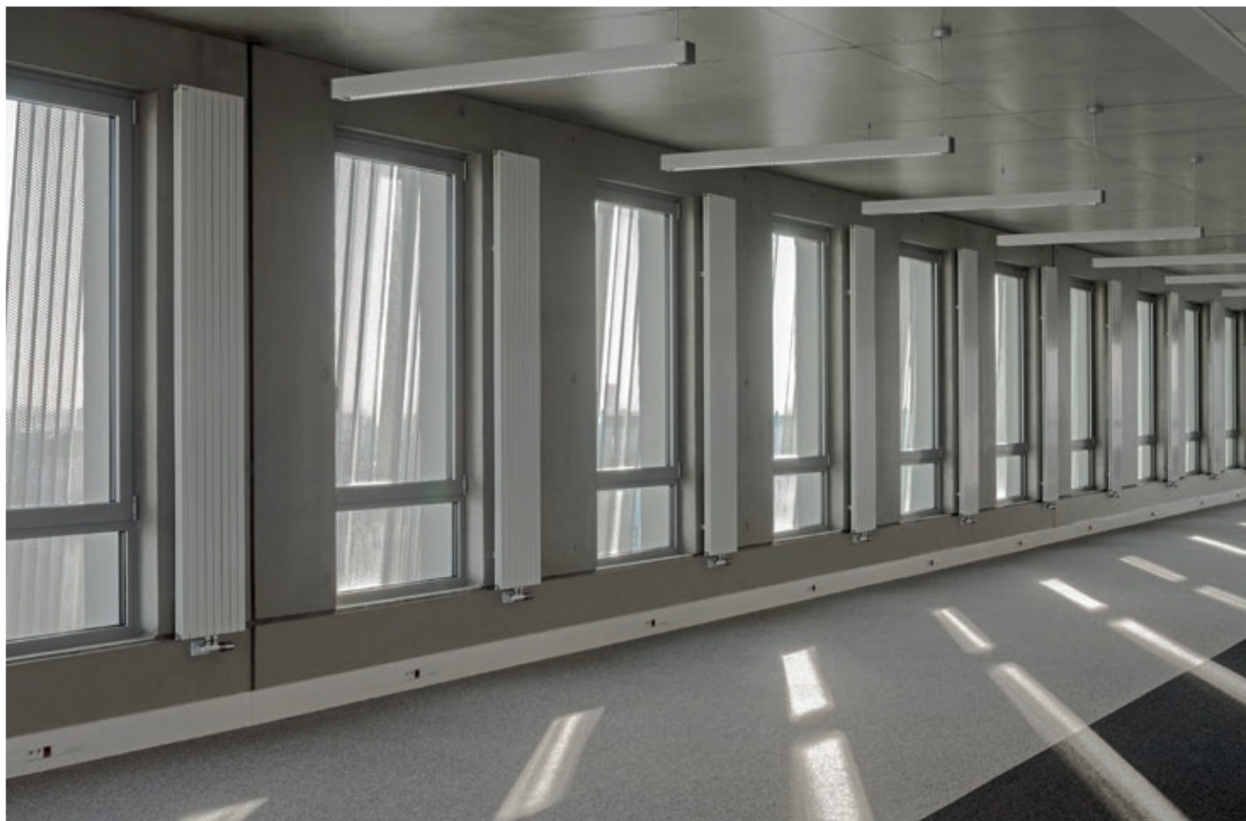
QUATUOR 3, Angers (49) - Architectes : Jacques Ferrier Architecture, Paris (75) Urbanmakers, Nantes (44) - Entreprise : Aluvair, La Guerche de Bretagne (35) - Photo : Karmel Khalfi
